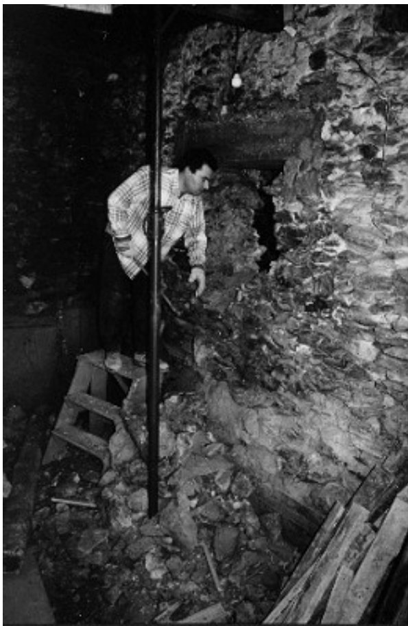
Marzo 1998: Apertura della porta interna di comunicazione fra le due stanze al piano terreno.
